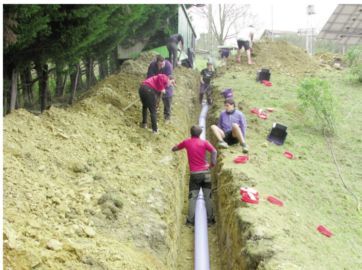
Eraikin eraginkor eta iraunkor berria, eta Efizientzia Energetikoa eta Eguzki Energia Termikoa tituluazioko ikasleak eraikuntza berriko putzu kanadiarraren muntaia egiten. USURBILGO LANBIDE ESKOLA
